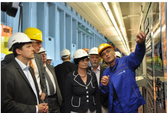
Im Maschinenraum des Pumpspeicherkraftwerkes Hohenwarte. (Bild: pbb)
